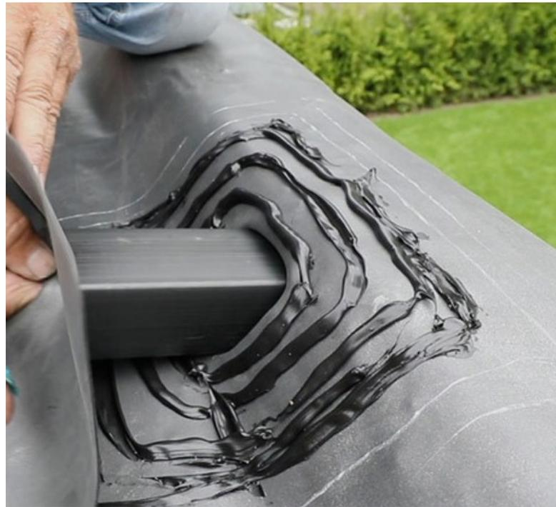
Membrane Adhesive ist ein hochwertiger, dauerelastischer Kleber auf Basis von MS-Polymeren mit ausgezeichneter Haftung auf vielen Kunststoffen und EPDM-Untergründen.
