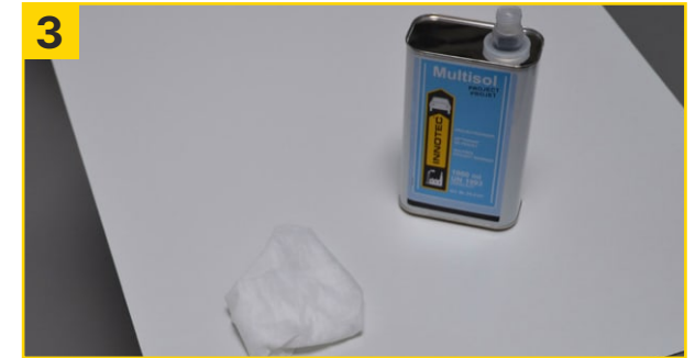
Die Fassadenplatten mit Multi Wipes Project und Multisol Project reinigen, mit einem sauberen Multi Wipes Project trocken wischen und ca. 10 Min. ablüften lassen. Falls Vorschrift, Platten grundieren!
