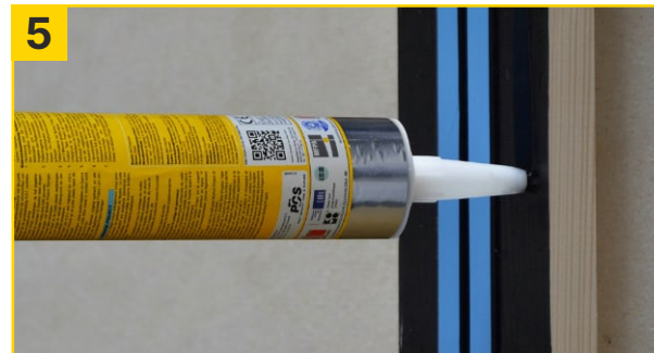
Adheseal Project parallel zum Klebeband (mind. 5 mm Abstand zwischen Fixation Tape Project 2 und Adheseal Project mit der mitgelieferten Spitze auftragen (8 mm-Raupe).
