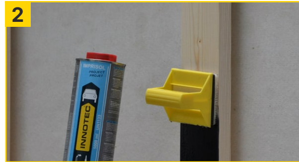
Imprisol Project auf die Holz-Unterkonstruktion auftragen und anschließend 10 Minuten ablüften lassen.
