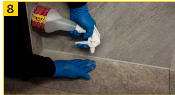
8 Seal Fluid auf die Fugen aufspritzen...
