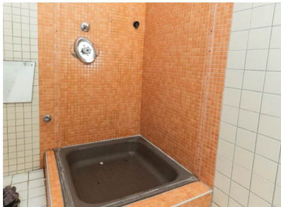
2000: Umbau des Badezimmers
