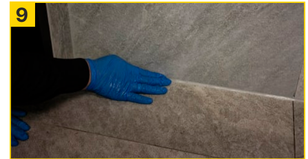
9 ...und vorsichtig abglätten. Fertig.
