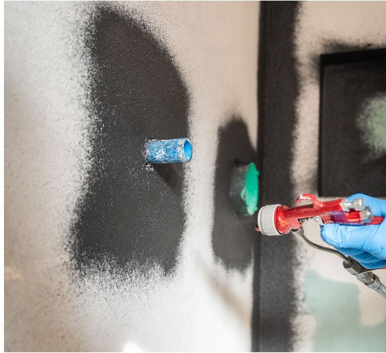
Unsere Dehnzonenmanschetten sind zum sicheren, schnellen und flexiblen Abdichten im Bereich der Nasszellen (Rohrdurchführungen).
