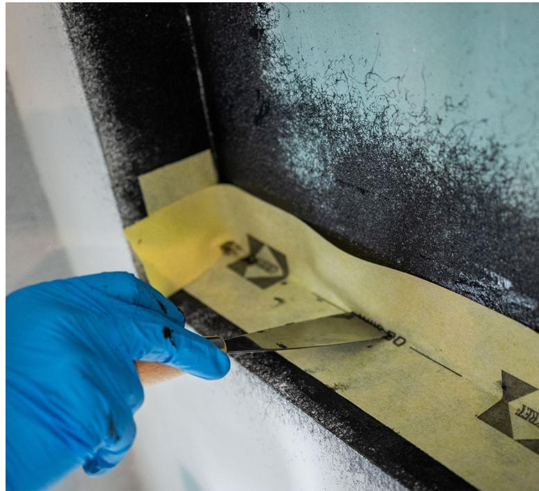
Unser flexibles, 3-lagiges Spezialdichtband ist Teil unseres Systems der Nasszellen-Abdichtung und dient als Überbrückung von Anschluss- und Bewegungsfugen.
