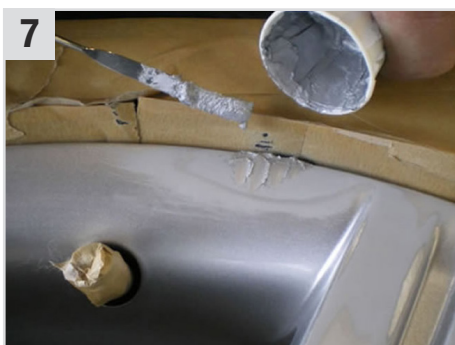
7 Mit Hilfe der Spatula (Rührstab) die Masse auf die beschädigte(n) Stelle(n) anbringen und verspachteln. (Offene Verarbeitungszeit ca. 10 Min.).
