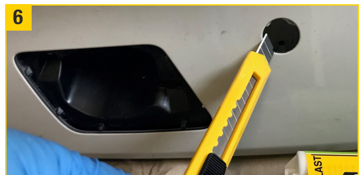
6 Eventuell überschüssiges Repaplast Fix (2K-PU-Klebstoff) wegschneiden. Fertig!
