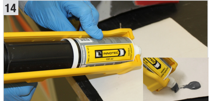
14 Repaplast Finish (2K-Kunststoffkitt) mithilfe der Easy Grip Gun (Kartuschenpistole) herausgepresst. Beide Komponenten müssen rauslaufen.
