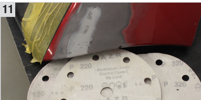
Reparierte Außenseite mit Royalcut (Runde Klettdisketten) K120 , K220 und K320 schleifen.
