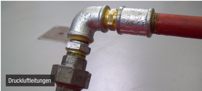
Undichte Dehnschrauben
