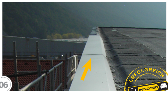
Überschüssiges Adheseal (Streichbare Klebedichtmasse) mit Multisol (Mehrzweck-Entfetter / Reiniger) und Multi Wipes Box (Universaltuch) entfernen
