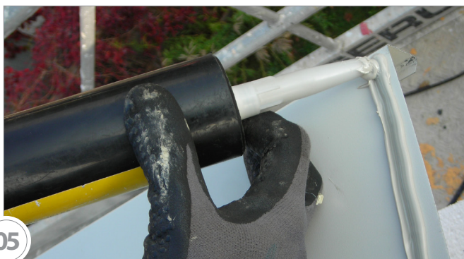
Stöße mit Adheseal (Streichbare Klebedichtmasse) ca. 2 - 3 cm überlappend zusammenkleben
