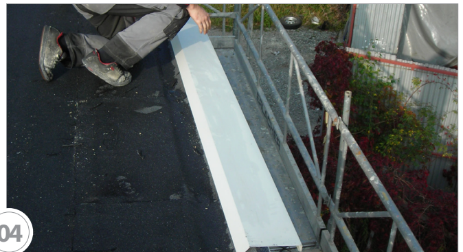
Anbringen des Windladens innerhalb von 10 Minuten (Hautbildung) (Achtung! Mindestabstand zum Unterbau mind. 1 - 2 mm)
