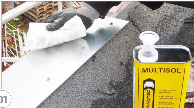
Unterbau mit Multisol (Mehrzweck-Entfetter / Reiniger) und Multi Wipes Box (Universaltuch) reinigen
