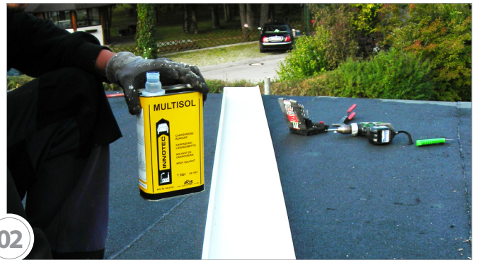
Windladen ebenfalls mit Multisol (Mehrzweck-Entfetter / Reiniger) und Multi Wipes Box (Universaltuch) reinigen
