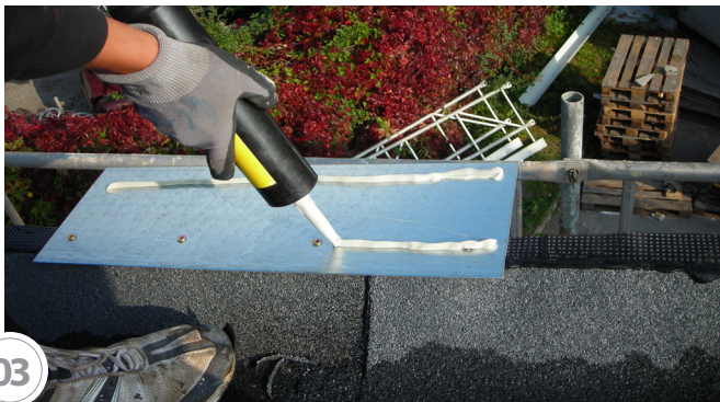
Auftragen von Adheseal (Streichbare Klebedichtmasse) mit der Pro 2000 Gun (ehem. Black Gun) (Kartuschenpistole) und einer Plastic Nozzle (Kartuschen-Spitzen)
