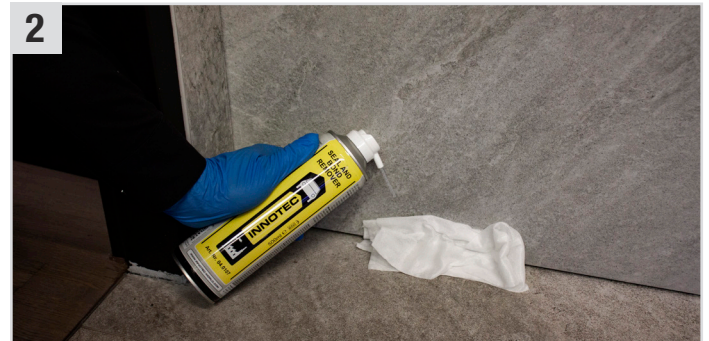
2 Mit Seal and Bond Remover (Klebstoff- & Dichtmassenentferner) und Multi Wipes (Universaltücher) die Stelle reinigen / entfetten (ca. 5 Min. ablüften lassen).
