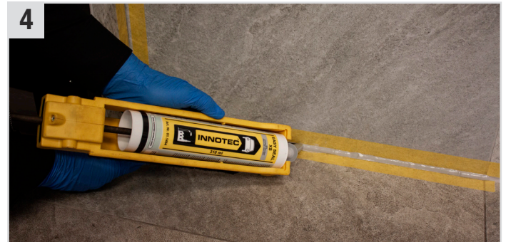
4 Easy Seal XS (Premium Silikondichtmasse) mit der Easy Grip Gun (Kartuschenpistole) auf der gewünschten Stelle auftragen.
