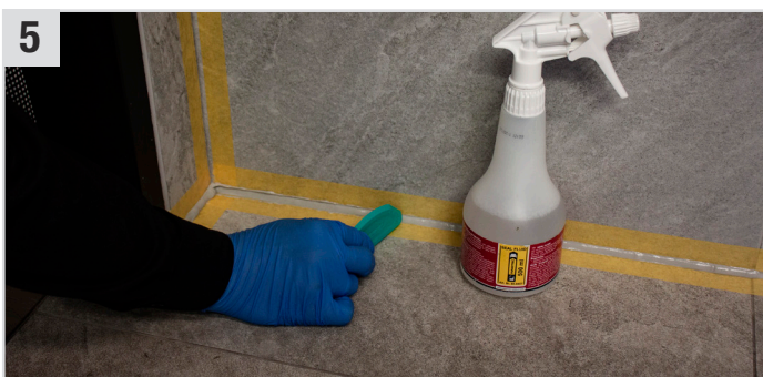
5 Die Fugenspachtel mit Seal Fluid (Lösungsmittelfreies Glättmittel) benetzen und die Dichtmasse abziehen.
