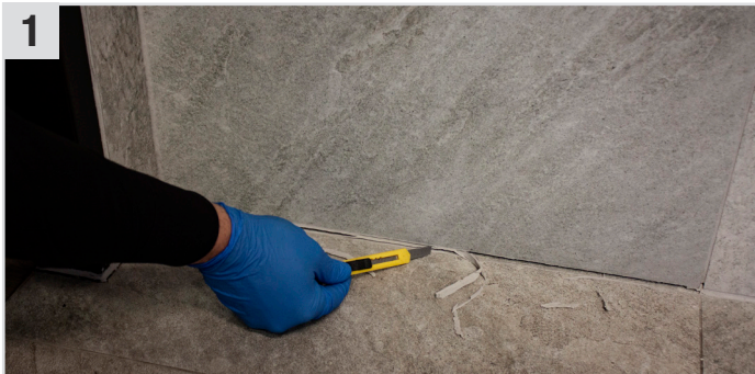
1 Alte Dichtmasse mit Seal and Bond Remover (Klebstoff- & Dichtmassenentferner) und Messer entfernen.
