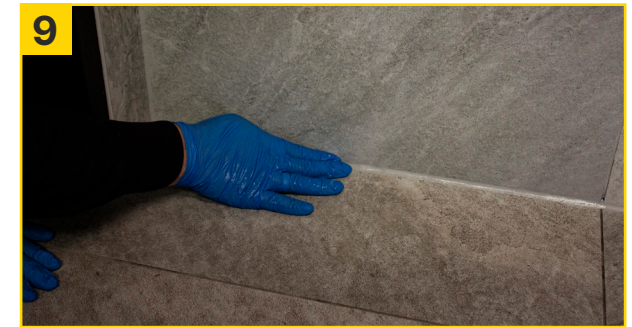
9 ...und vorsichtig abglätten. Fertig.
