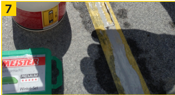
7 Die Finger mit Seal Fluid einsprühen und vorsichtig abglätten.
