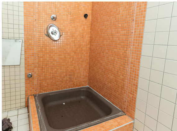
2000: Umbau des Badezimmers
