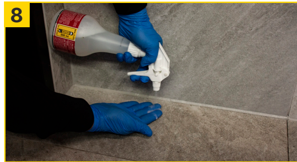
8 Seal Fluid auf die Fugen aufsprühen...
